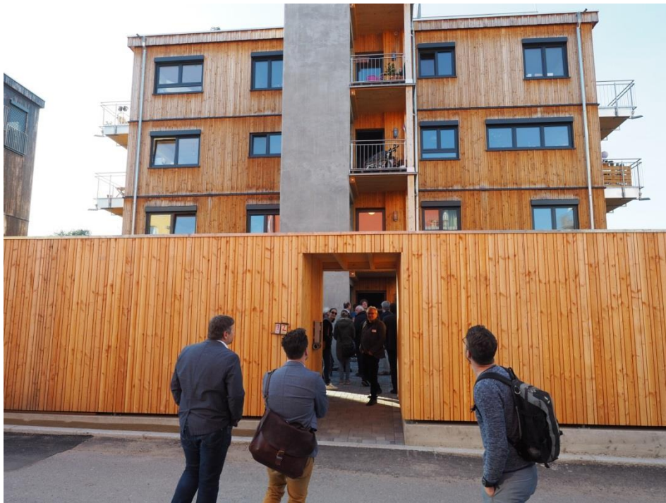
Die Besucher bei der Besichtigung von 4W (Öko-Plan, Donaueschingen), ein viergeschossiger Holzmassivbau mit einem besonderen Heizungskonzept .
