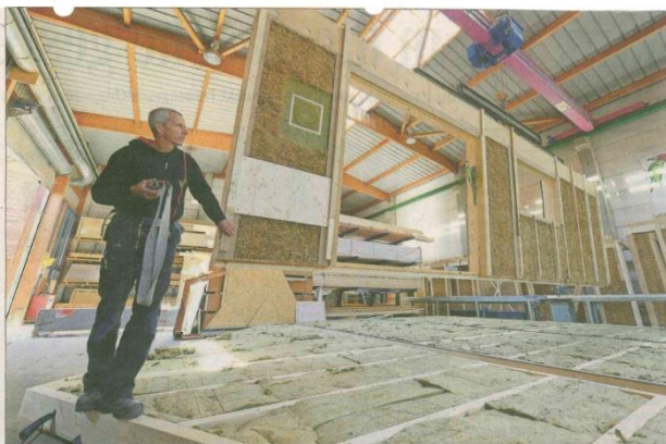
Matthias Wörner von der Freiburger Zimmerer Grünspocht hat eine Holzwand mit Strohdämmung in Elementbauweise am Haken.
